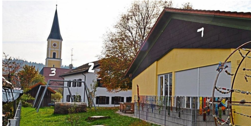
Auf kurzem Wege können Kindergarten (1), neuer Pfarrhof (2) und Alter Pfarrhof (verdeckt) sowie die Kirche (3) mit Nahwärme versorgt werden. – Foto: Thurnreiter
